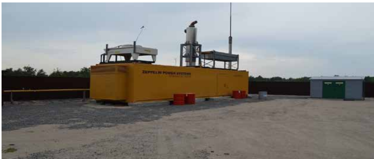
Рис. 3. Конегераційна установка ТОВ «ЛНК»
